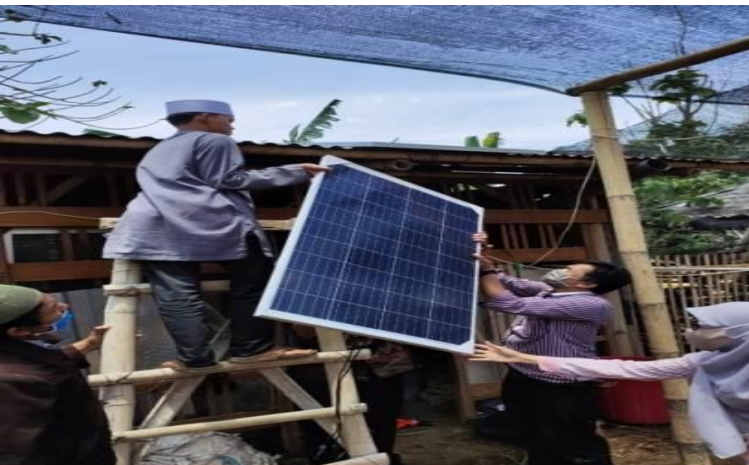
Gambar 6. Proses pemasangan panel surya yang akan mendukung sistem bioflok
